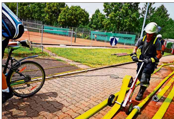
Aufräumarbeiten durch die Feuerwehr.
